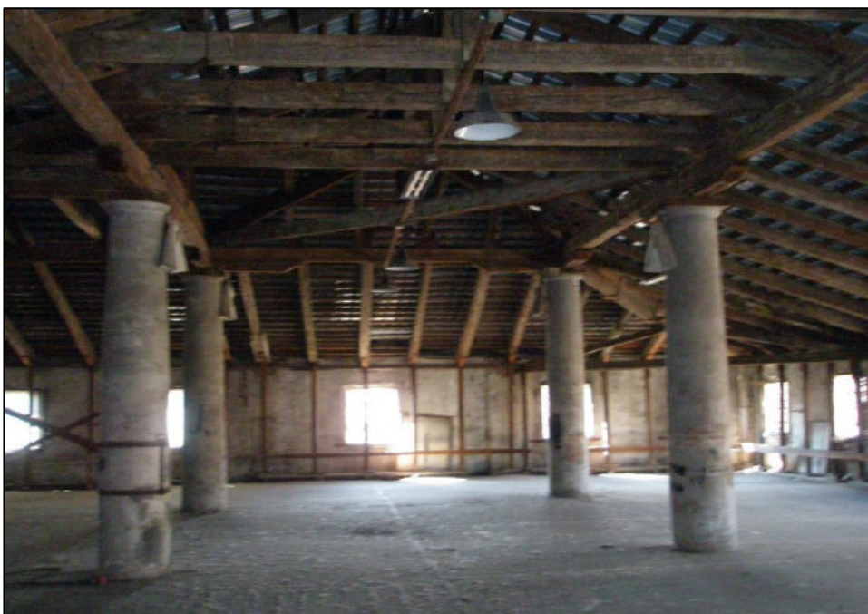
Ripresa fotografica interna del piano primo, lato sud
