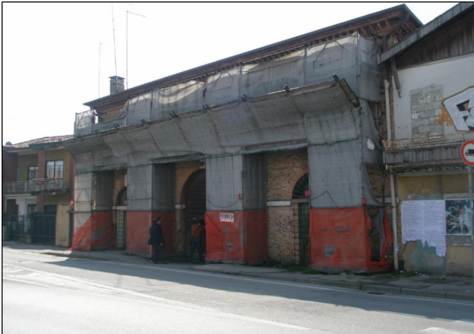
Ripresa fotografica esterna fronte nord su via Pepe
