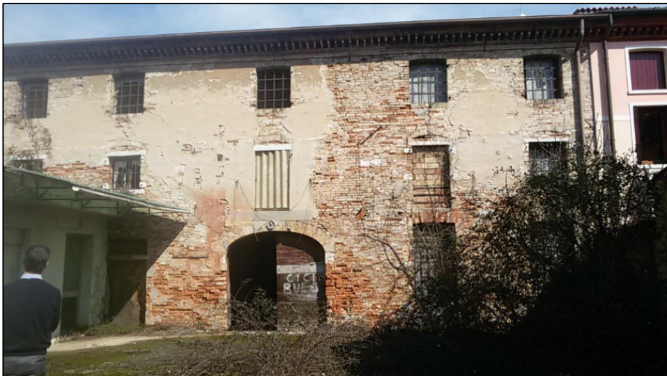
Ripresa fotografica esterna fronte sud sul cortile interno
